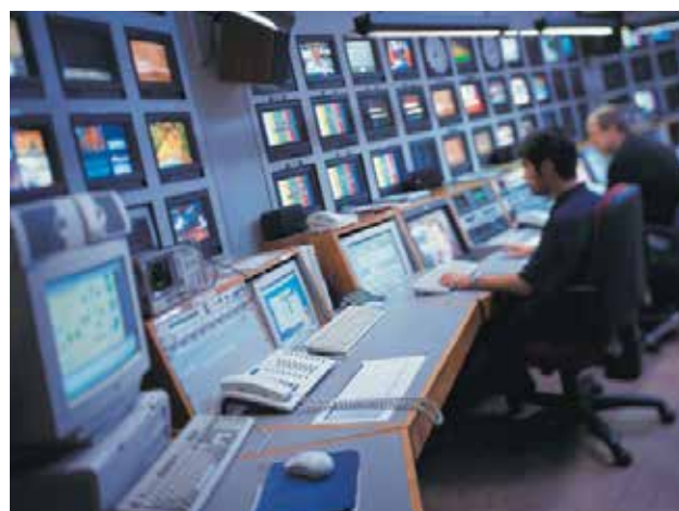
RDU-Cooling 监控界面
